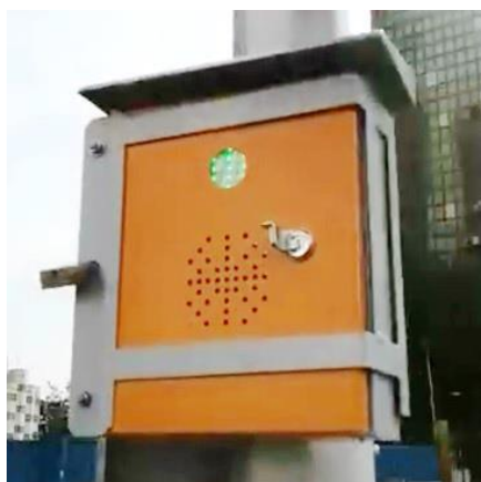
شکل ۳۹-۲ نمونه سامانه اعلام صوتی وضعیت چراغ عابر پیاده
